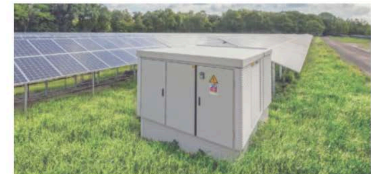
Referentie van een transformator.
